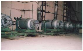
In russischen Wasserwerken wird häufig Chlorgas zur Desinfektion des Trinkwassers eingesetzt. Das Chlor lagert in Tanks wie hier im Lager Rubljovo nordwestlich von Moskau. In Deutschland kommen auf Grund der Sicherheits- und Umweltrisiken alternative Desinfektionsverfahren zum Einsatz. Foto: Michael König
