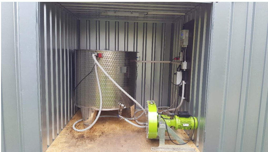
Abbildung A 2: Feststoffsammler an der Alb oh. Pulverhausstraße
