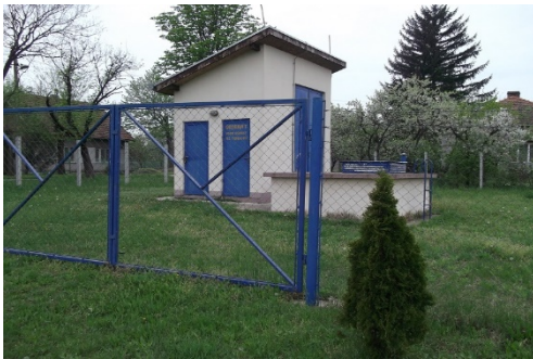
Kleine Trinkwasserversorgung im Dorf Tornjoš
