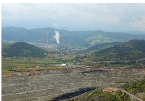
Otvoreni kop uglja i termoelektrana Pljevlja Crna Gora
