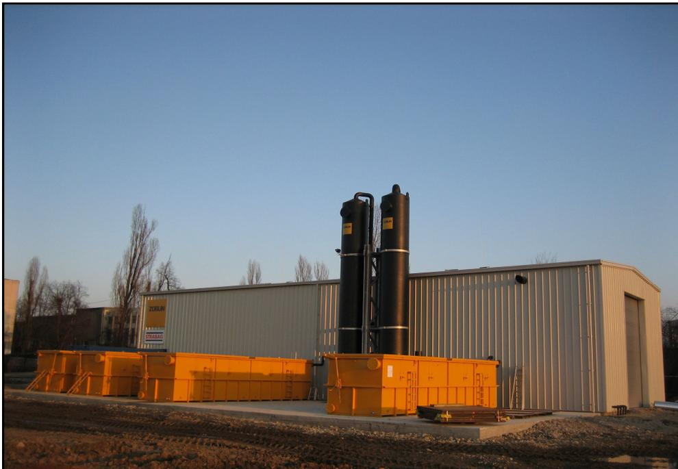
**Foto 15:** Grundwassersanierungsanlage (Halle mit Containern) (Quelle: Züblin)
