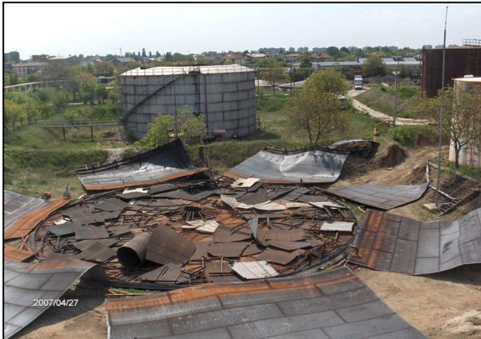
**Foto 5:** Abbrucharbeiten Tanks – Tankhöfe wurden nach Bodensanierung verfüllt
