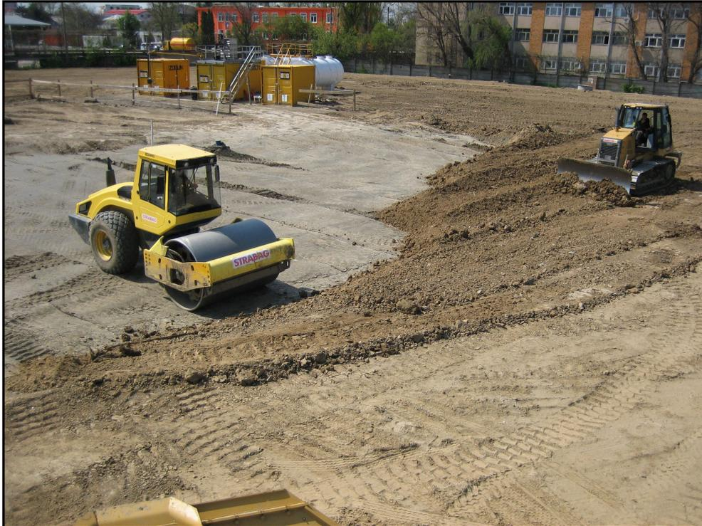
**Foto 8:** Wiedereinbau von biologisch behandeltem sanierten Boden
