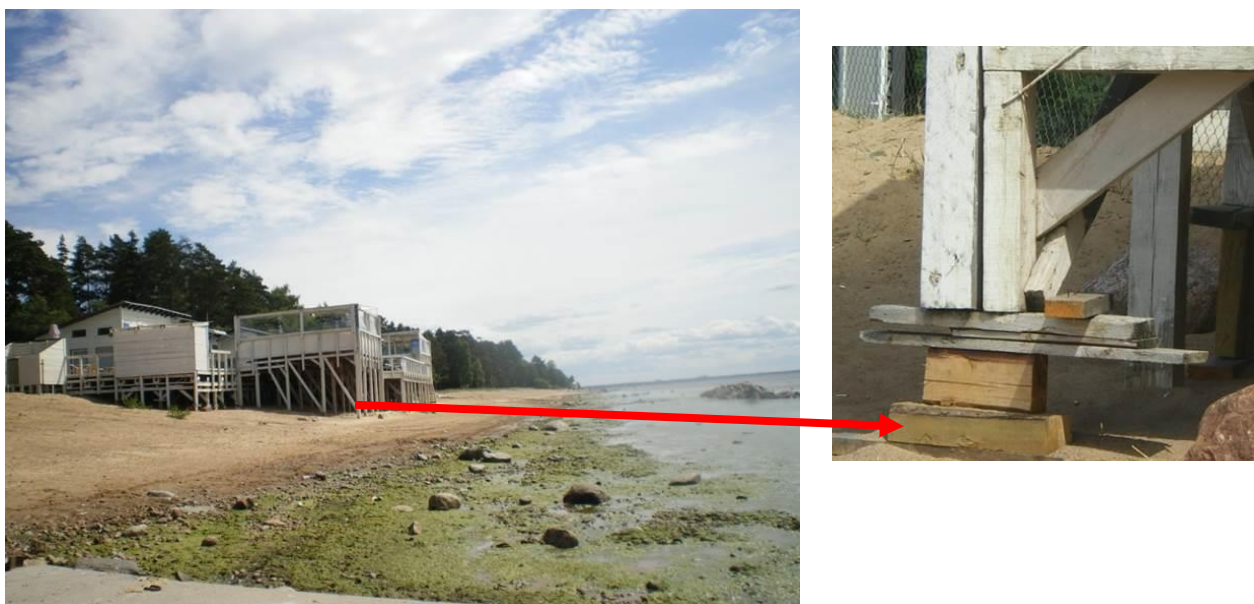
Рис. 7: Изменение береговой линии (эрозия берега) вблизи пос. Комарово, эвтрофикации вследствие хаотичного строительства берегозащитных сооружений
