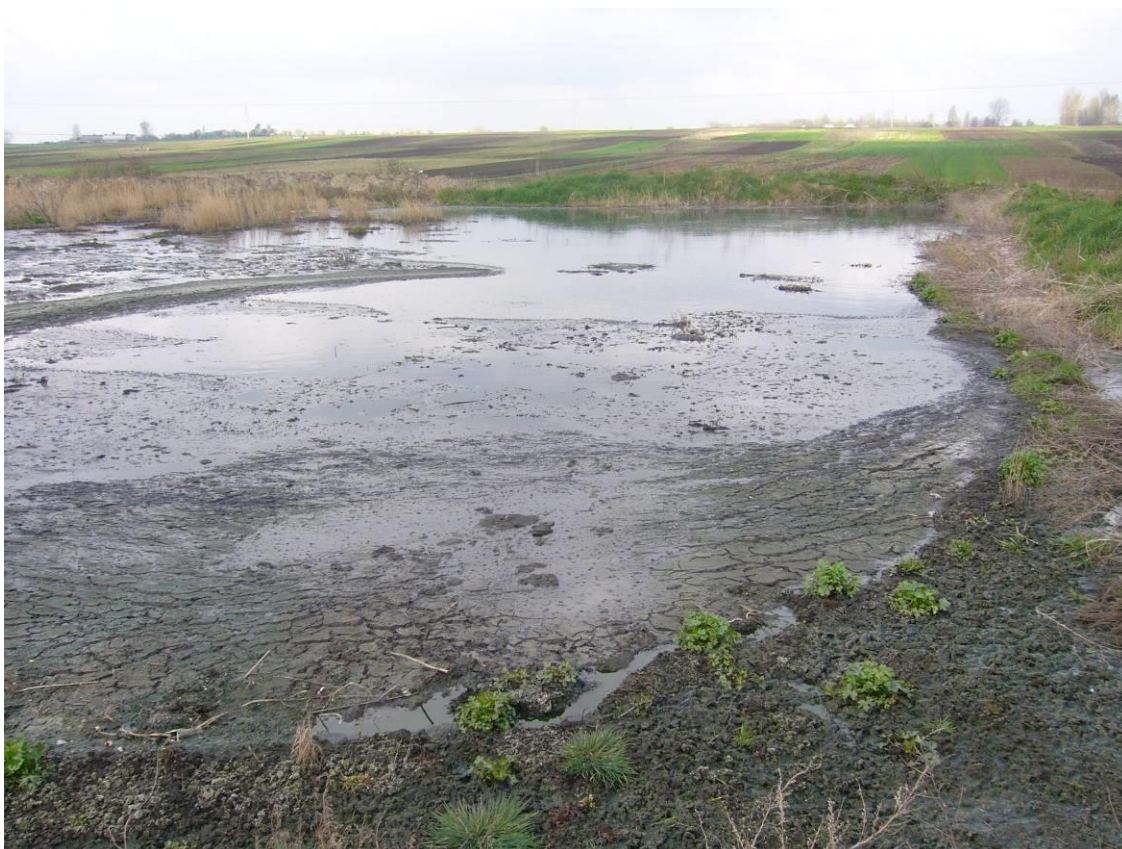
Малюнок 9: Переповнені мулові майданчики на очисних спорудах м. Червоноград
