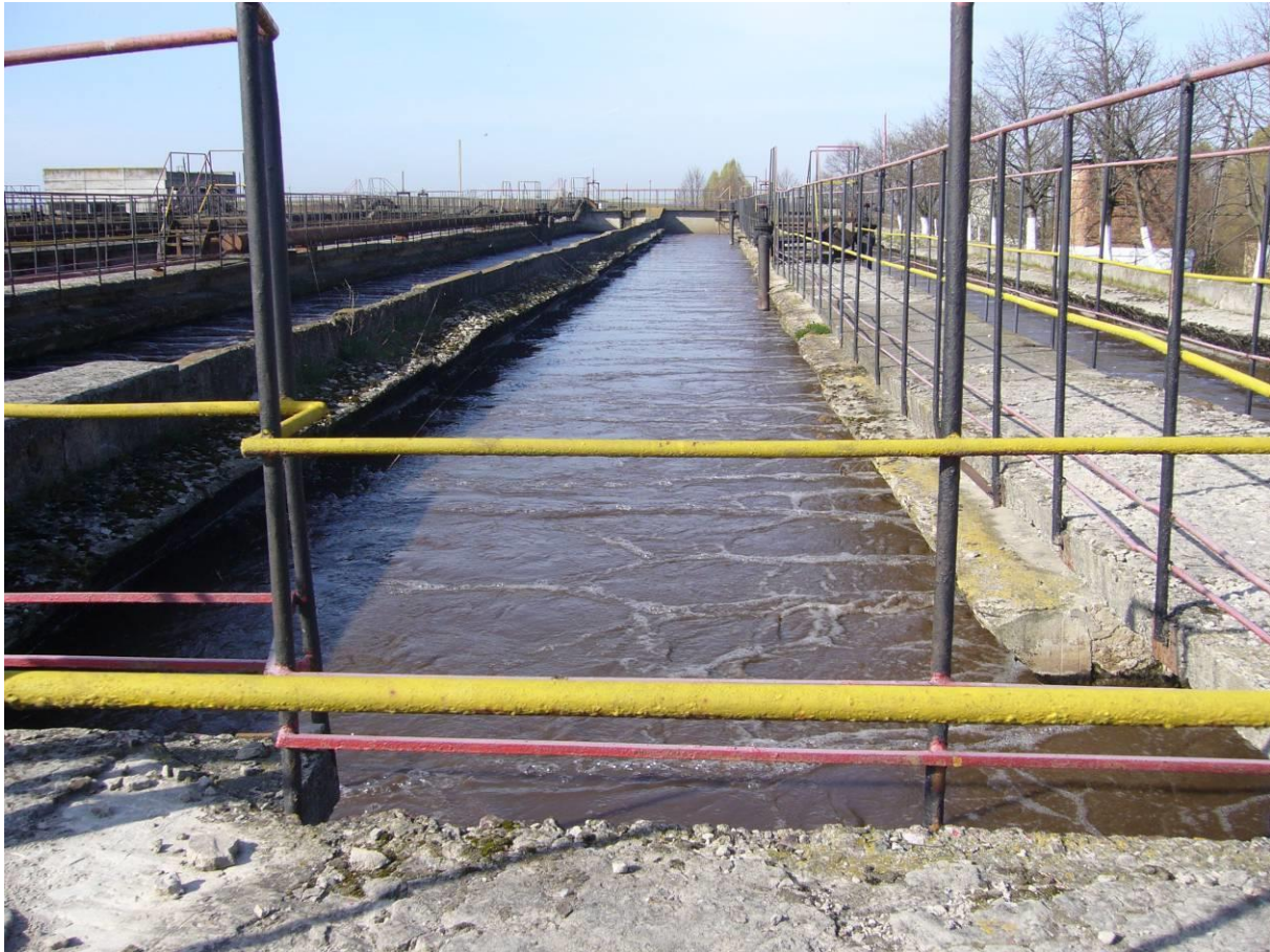
Малюнок 12: Аеротенки на очисних спорудах м. Нововолинськ
