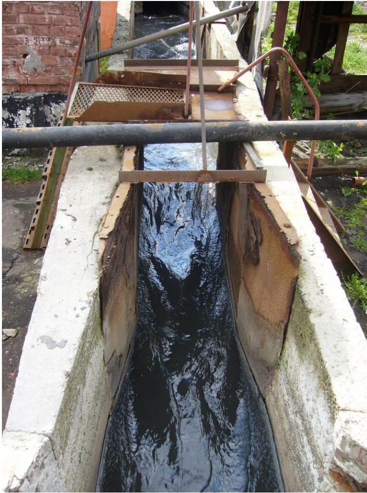
Малюнок 14: Вимірювальний канал Вентурі на вході ОС м.Червоноград
