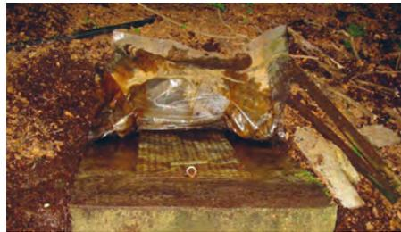
*Quellfassung mit undichter Abdeckung und Gefahr des Übersülens (Hanglage)*
