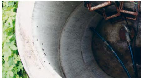
*Schädlinge im Schacht durch nicht dicht aufliegenden Deckel*
