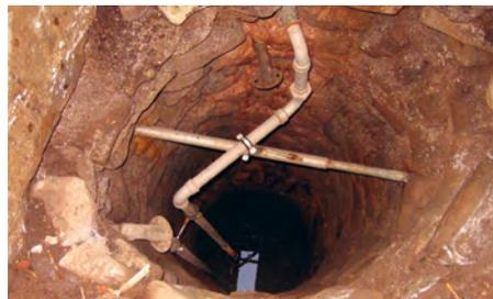
*Korrodierte Rohre, starke Eisenoxidausfällungen*
