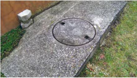
*Risse in der Betoneinfassung führen zu Undichtigkeiten*
