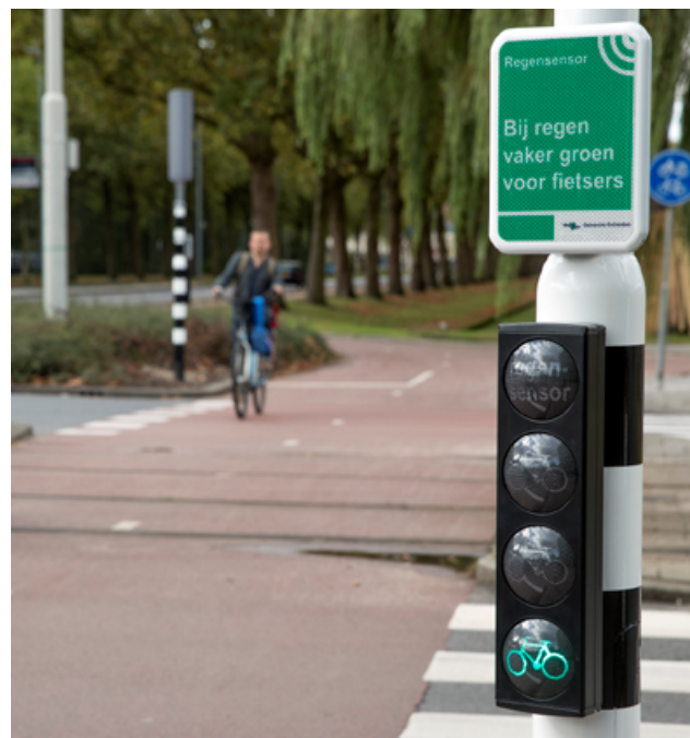
Abbildung 7: Regensensoren für häufigere Grünphasen in Rotterdam
