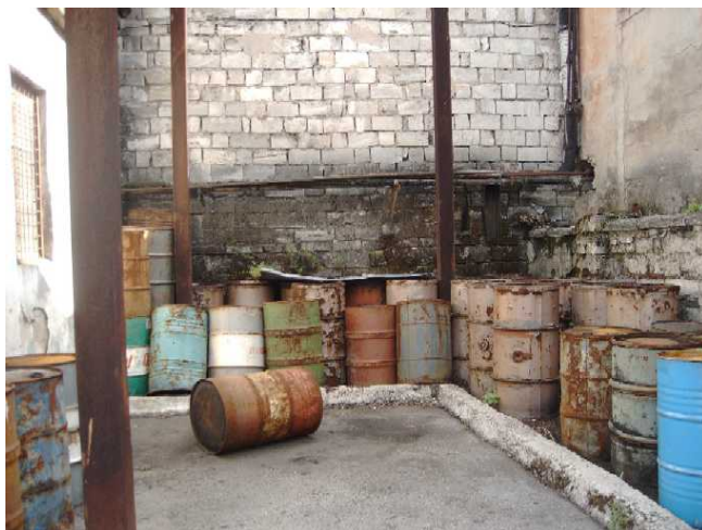
Abbildung 19: Gebindelager für Mineralöle
