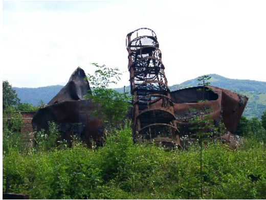
Abbildung 4: Zerstörter Schweröltank unmittelbar neben der Theiß
