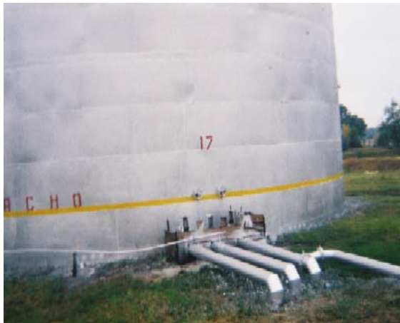
Abbildung 3: Flachbodentank in einem Auffangraum bestehend aus einem lehmhaltigen Boden und Erdwällen
