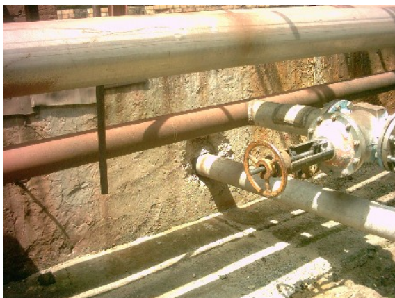
Abbildung 9: Rohrdurchführung im Auffangwannenbereich
